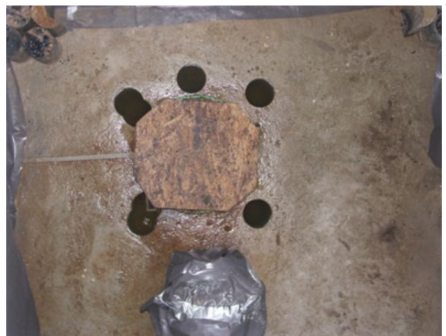
Abb. 2 – Lage der Verpressbohrungen um den Brunnenkopf
