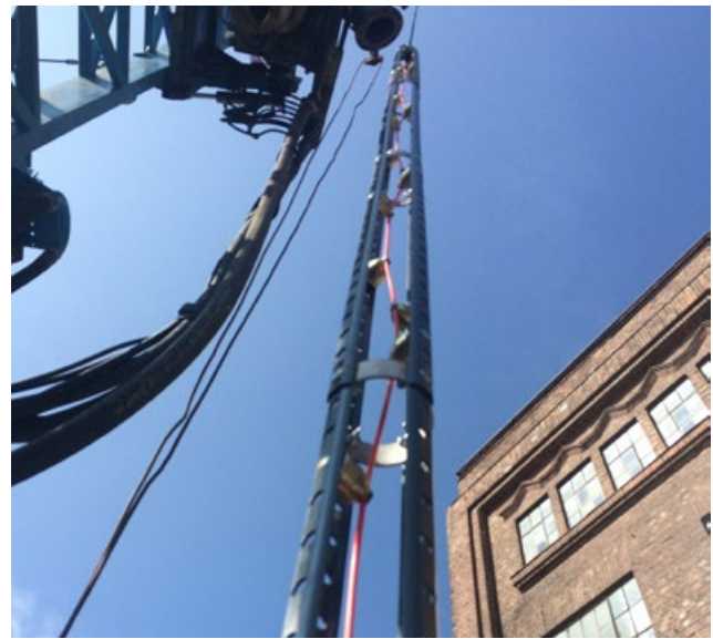
Abb. 5 – Einbau eines Korbes mit versetzt angeordneten Hohlladungen
